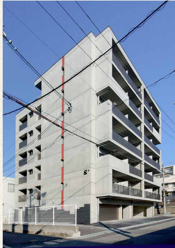
【神戸市中央区／鉄筋コンクリート造7階建／マンション／2014年3月竣工】 月極駐車場を開発した単身者向け賃貸マンション。優れた企画が生み出す収益性と、入居者に満足頂ける仕様を緻密にプランニングし、激戦の賃貸住宅エリアで高い稼働率を維持しています。
