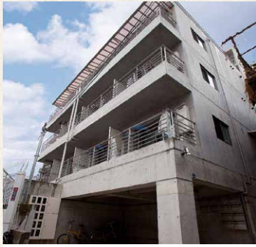
神戸・山手アパートメント／神戸市中央区
