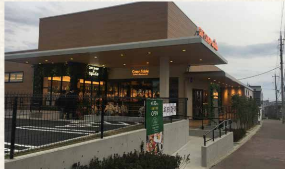
【神戸市西区 / 鉄骨造1階建 / 店舗 / 2017年3月竣工】 区画整理の新興住宅街内の生活道路に面した農地にギフトショップ「apide」を誘致しました。
