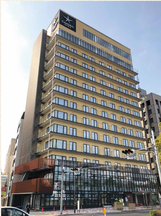
【神戸市中央区 / 鉄骨造15階建 / ホテル / 2018年3月竣工】 震災の傷跡が残るテナントビル3棟が建っていた神戸三宮のトアロード沿いに、フォースターホテル<カンデオホテルズ神戸トアロード>を誘致しました。 都心の商業地での計画においては、敷地の容積率を最大限に活かすことが重要です。建物は、展望風呂とレストランを完備した160室のホテルと店舗で計画され、敷地を最大限に活かした有効利用が実現できた事例です。
