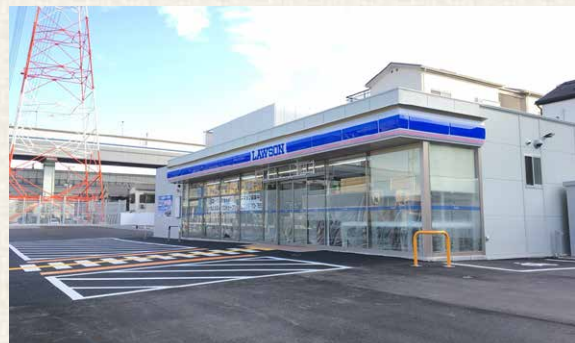
【尼崎市 / 鉄骨平屋建 / コンビニエンスストア / 2018年2月竣工】 電力会社様が所有する高圧線下の未利用地を活用。高速道路I.C間を結ぶ交通量の多い幹線道路に面する土地特性を活かし、ロードサイド型店舗を誘致した事例です。
