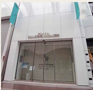
三宮MINAMIビル／神戸市中央区
