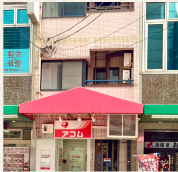
雲井ビル／神戸市中央区
