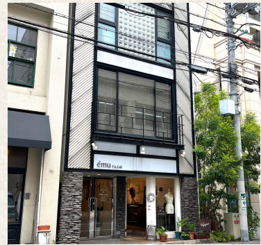
SPC ビル／神戸市中央区
