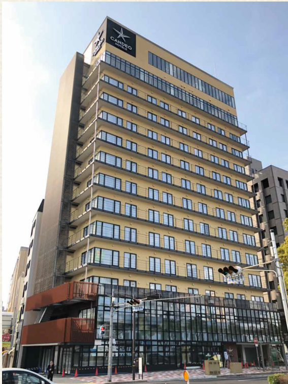
【神戸市中央区／鉄骨造15階建／ホテル／2018年3月竣工】
